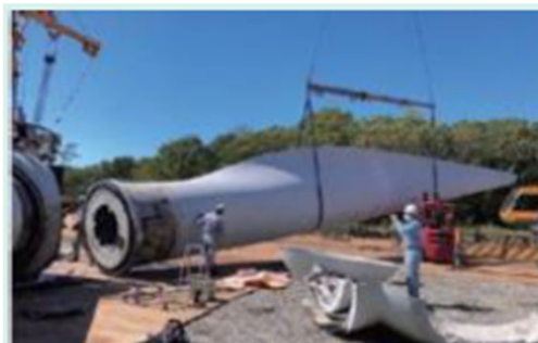
例：風力発電のブレード の解体
