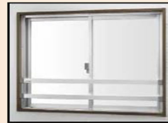
転落防止の手すりの設置
